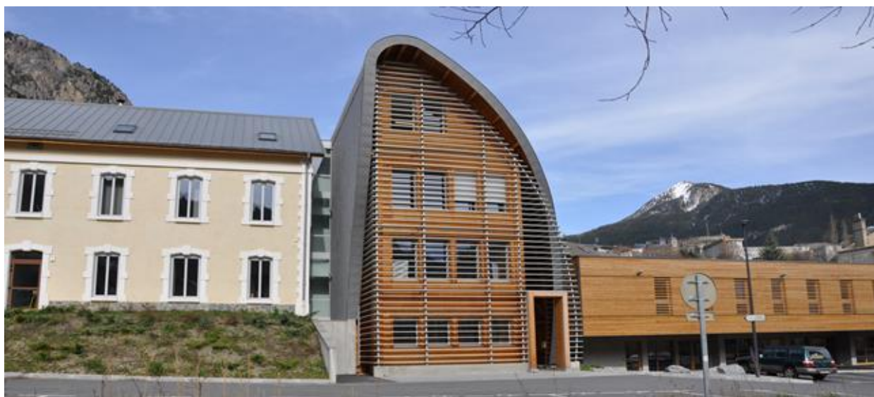
Les locaux d'Altipolis à Briançon : l'arche formant le A d'Altipolis, accolée à un bâtiment rénové de la caserne Berwick et à droite, l'hôtel d'entreprises. Crédit : Altipolis.
