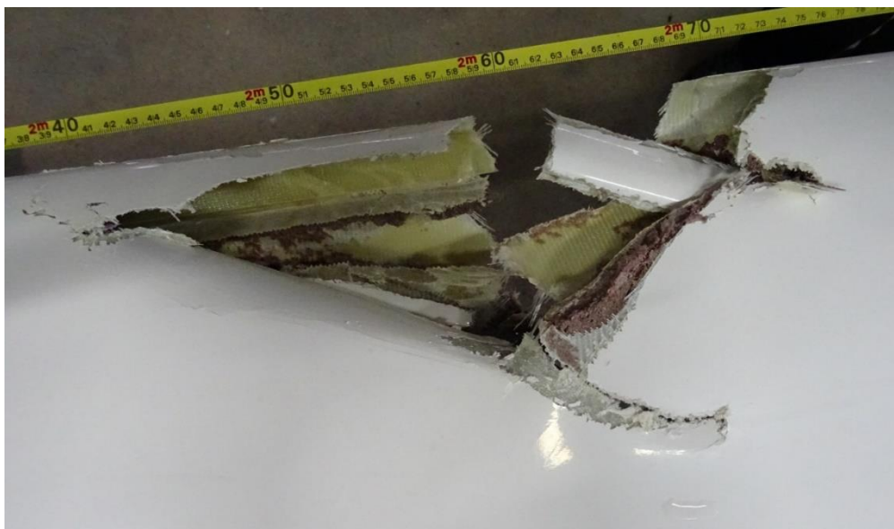
Figure 4 : endommagement du bord d'attaque de l'aile gauche du Z100, vu du dessus
