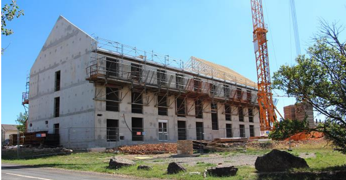
Installation de la 13 ème DBLE à la Cavalerie : construction du bâtiment de vie. Crédit Photo : Officier com – 13 ème DBLE
