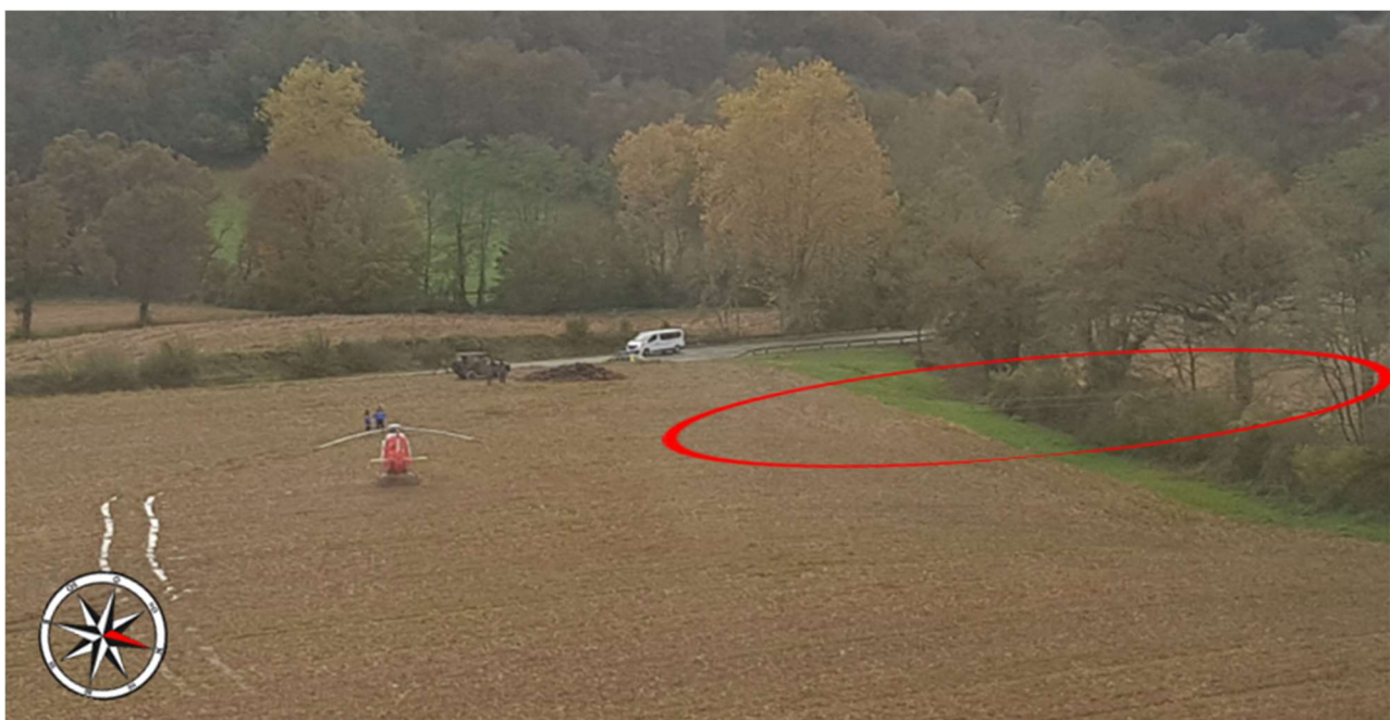
Figure 10 : ligne électrique peu visible après réparation
