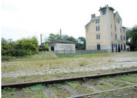
Ancienne gare de déportation (Bobigny, Seine-Saint-Denis)
