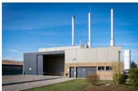
Chaufferie biomasse sur le camp de la Valbonne.
