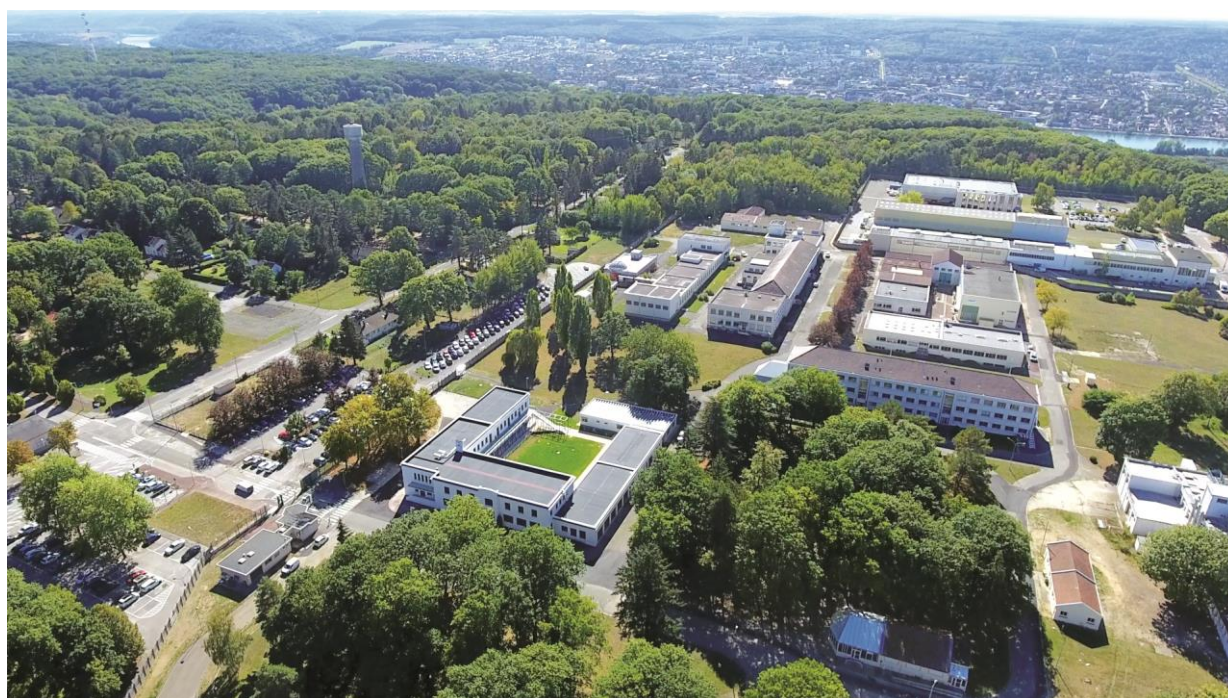
« Campus de l'espace » à Vernon –© F.D. film
