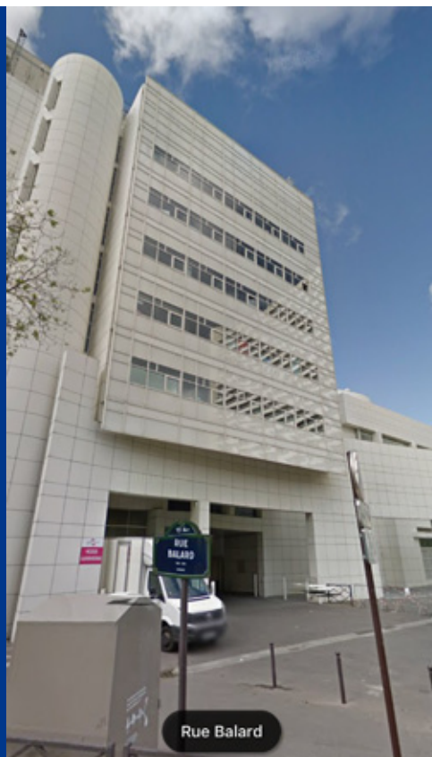
Accès au bâtiment (Sous l'arche, première porte à gauche)
