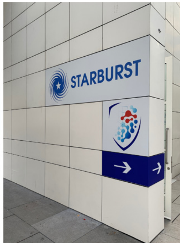
Porte d'accès au bâtiment
