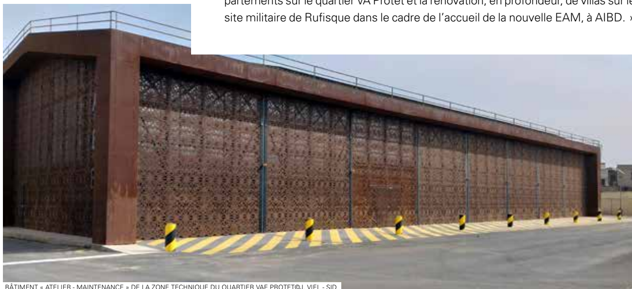
BÂTIMENT « ATELIER - MAINTENANCE » DE LA ZONE TECHNIQUE DU QUARTIER VAE PROTET@J. VIEL - SID
