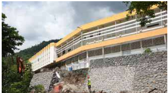
RENFORCEMENT DU MUR DE SOUTÈNEMENT DE LA RAVINE GENTILLE AU SEIN DE LA CASERNE LAMBERT, À SAINT-DENIS (DID SAINT-DENIS)©D.R. - SID
