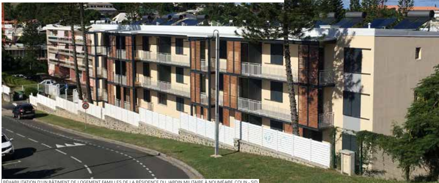
RÉHABILITATION D'UN BÂTIMENT DE LOGEMENT FAMILLES DE LA RÉSIDENCE DU JARDIN MILITAIRE À NOUMÉA © F. COLIN - SID
