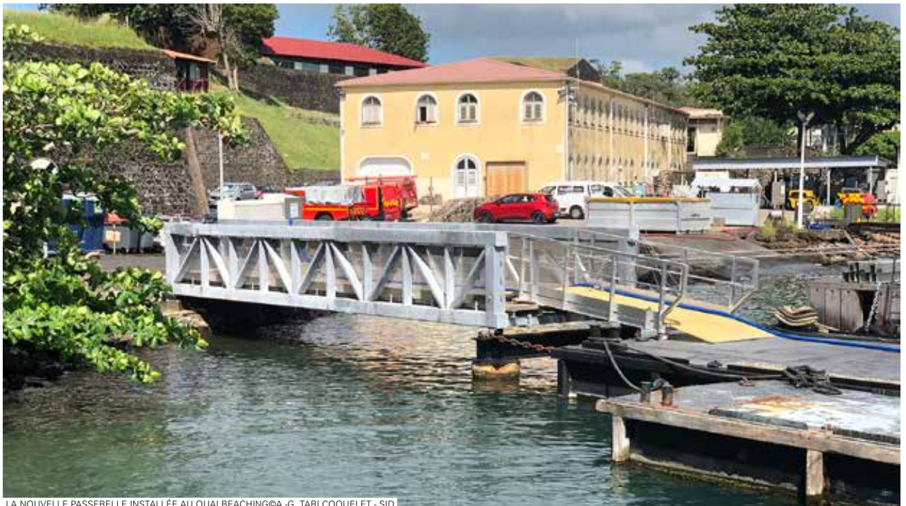
LA NOUVELLE PASSERELLE INSTALLÉE AU QUAI BEACHING@A.-G. TARI COQUELET - SID
