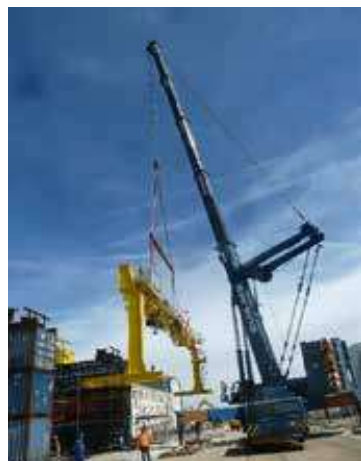
GRUTAGE D'UN PONT-PORTIQUE (ESID RENNES) ©D.R.
