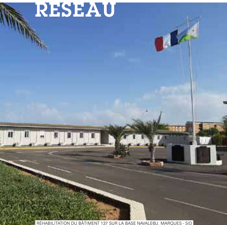
RÉHABILITATION DU BÂTIMENT 137 SUR LA BASE NAVALE@J. MARQUES - SID
