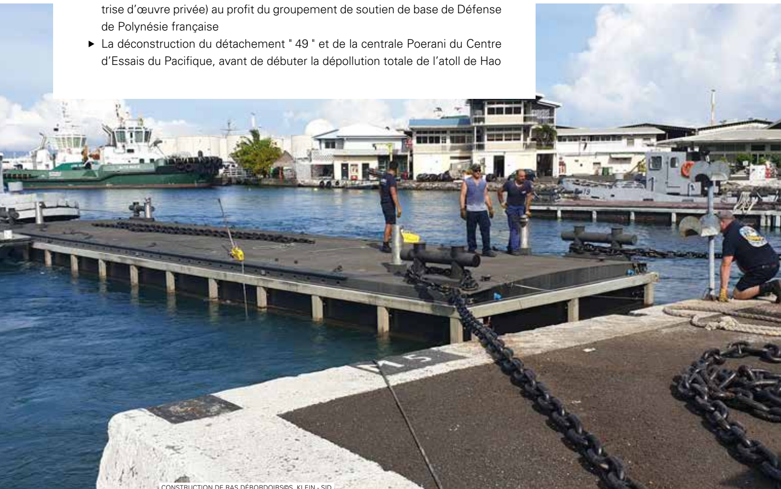
CONSTRUCTION DE RAS DÉBORDOIRS © S. KLEIN - SID
