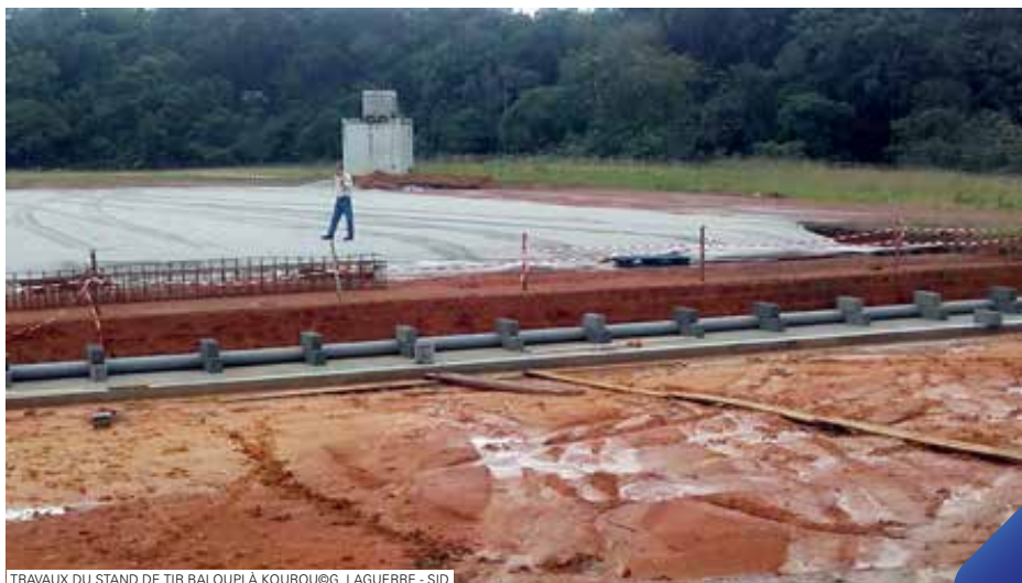
TRAVAUX DU STAND DE TIR BALOUPÏ À KOUROU@G. LAGUERRE - SID
