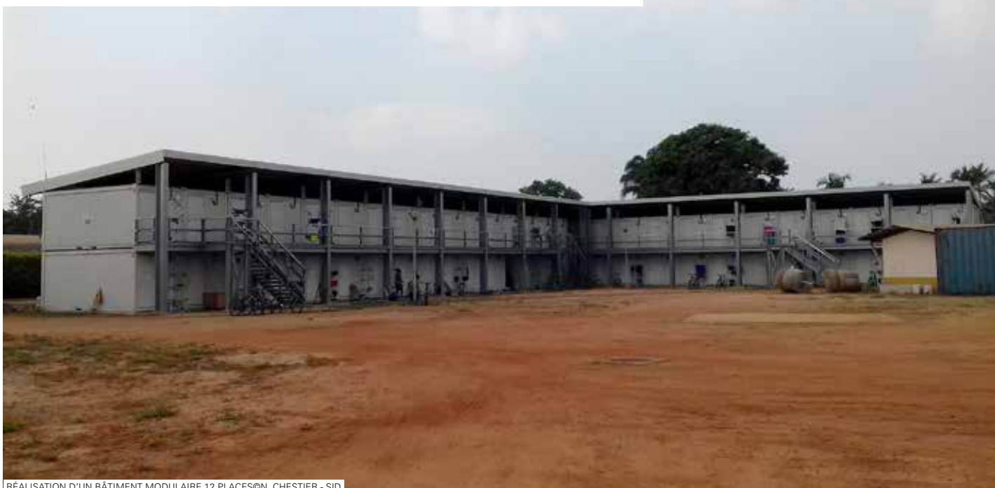
RÉALISATION D'UN BÂTIMENT MODULAIRE 12 PLACES ©N. CHESTIER - SID
