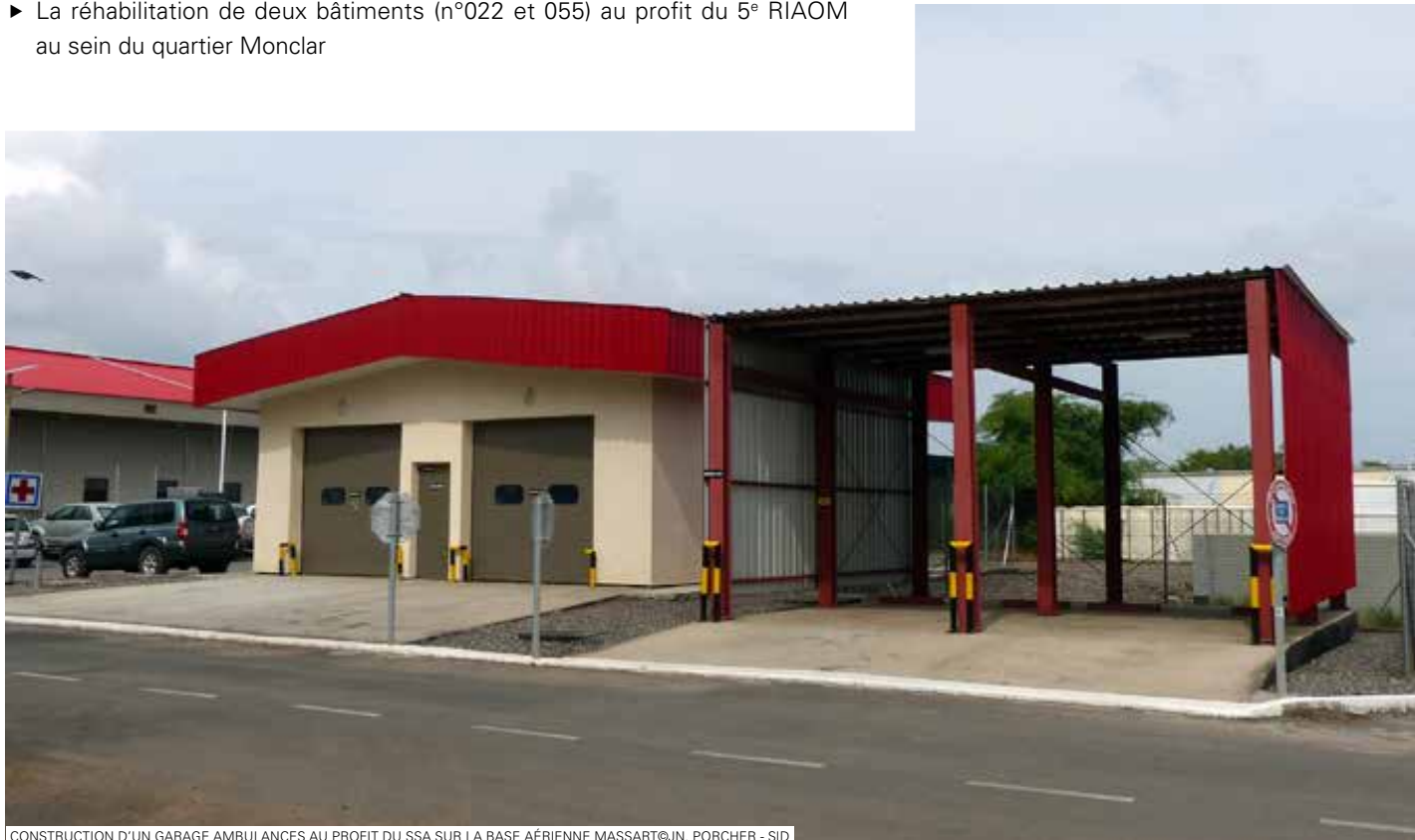
CONSTRUCTION D'UN GARAGE AMBULANCES AU PROFIT DU SSA SUR LA BASE AÉRIENNE MASSART@JN. PORCHER - SID
