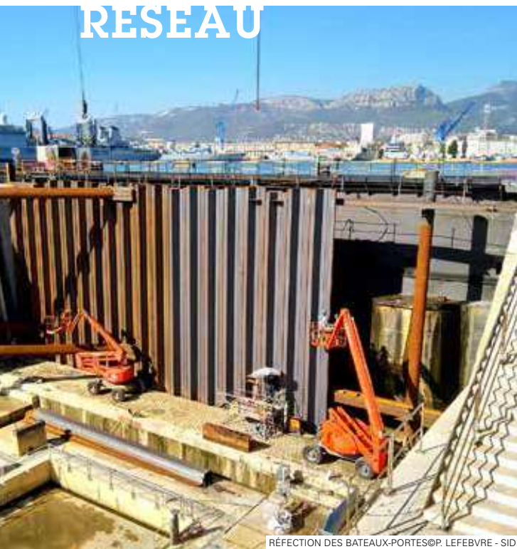
RÉFECTION DES BATEAUX-PORTES © P. LEFEBVRE - SID
