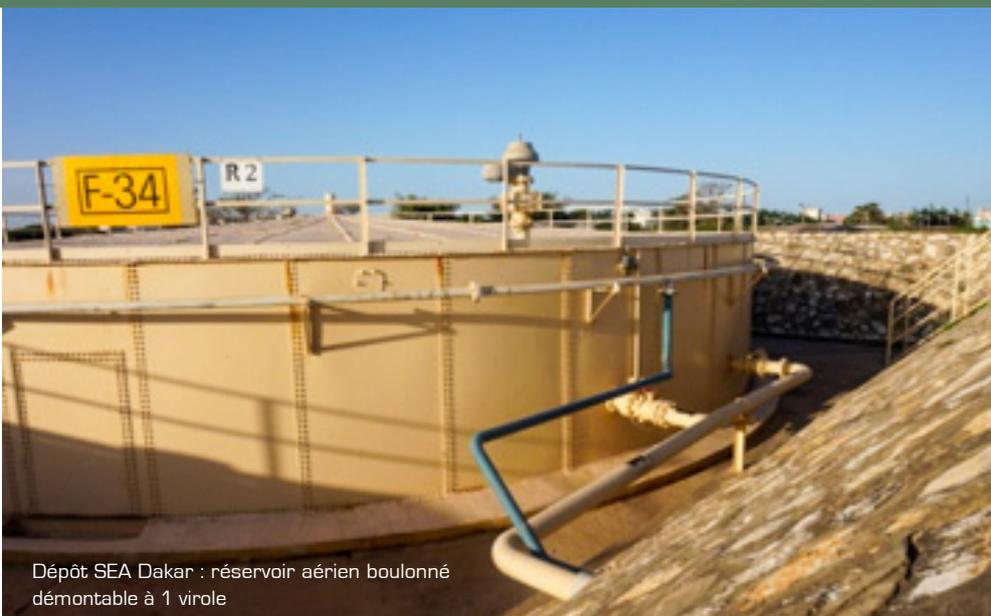
Dépôt SEA Dakar : réservoir aérien boulonné démontable à 1 virole
