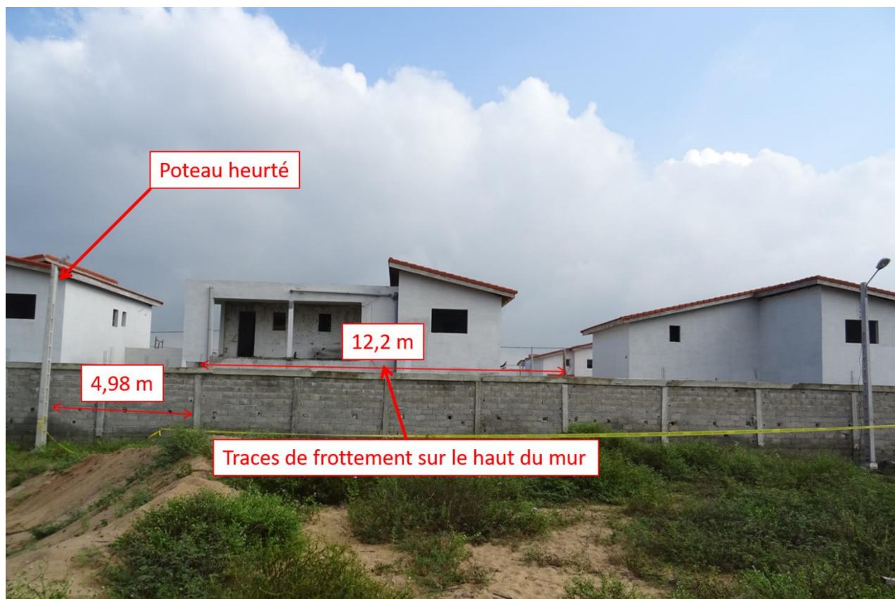
Figure 5 : mur endommagé
