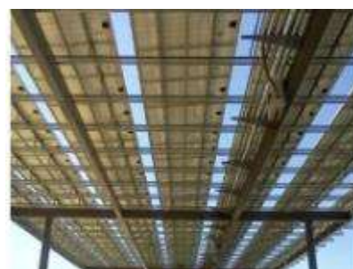
Figure 4 : Création à Fort Hunter Liggett d'un toit de 6 m de haut pour y poser des panneaux photovoltaïques Source : Lessons Learned in Net Zero Energy, op. cit
