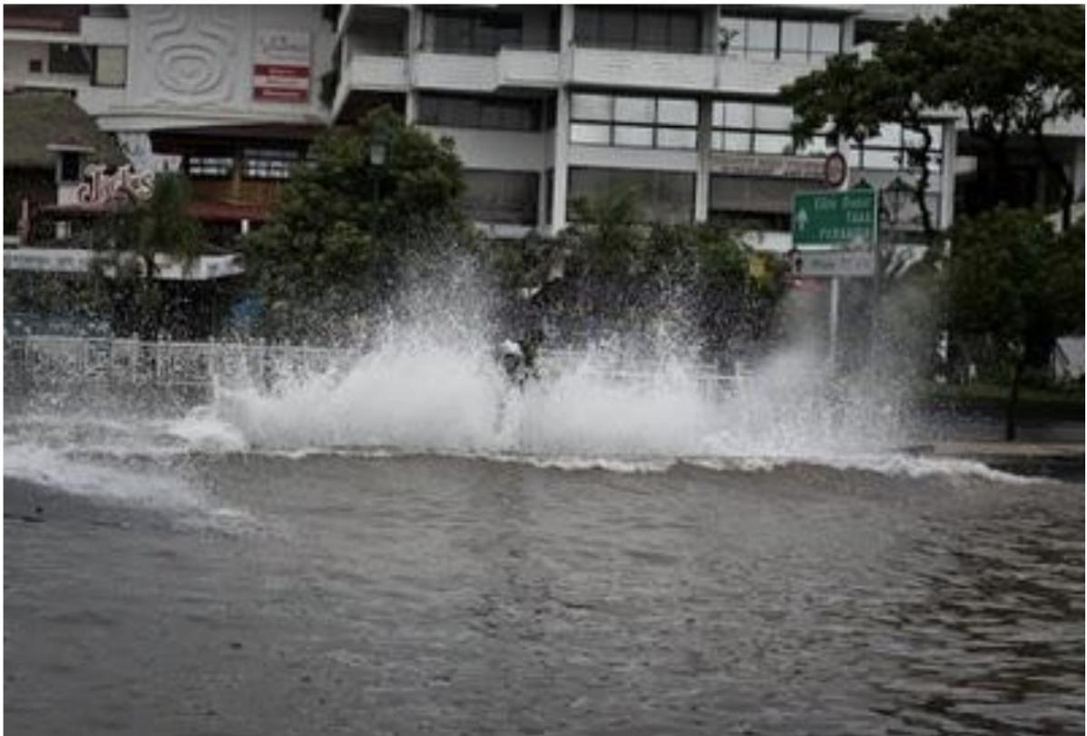
Fig. 3 – Inondation de la route côtière à Papeete durant le cyclone Oli (2010).
