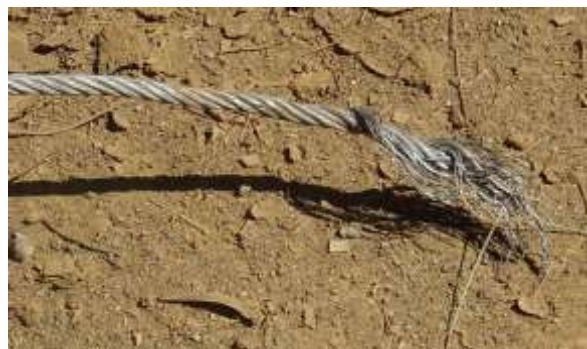
Figure 5 : vue d'un des deux câbles de 7 millimètres de diamètre
