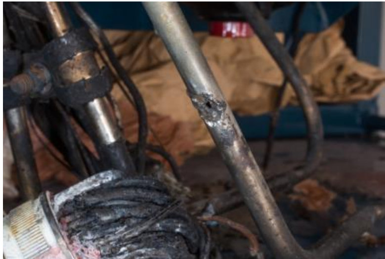
Figure 8 : perforation de la canalisation carburant
