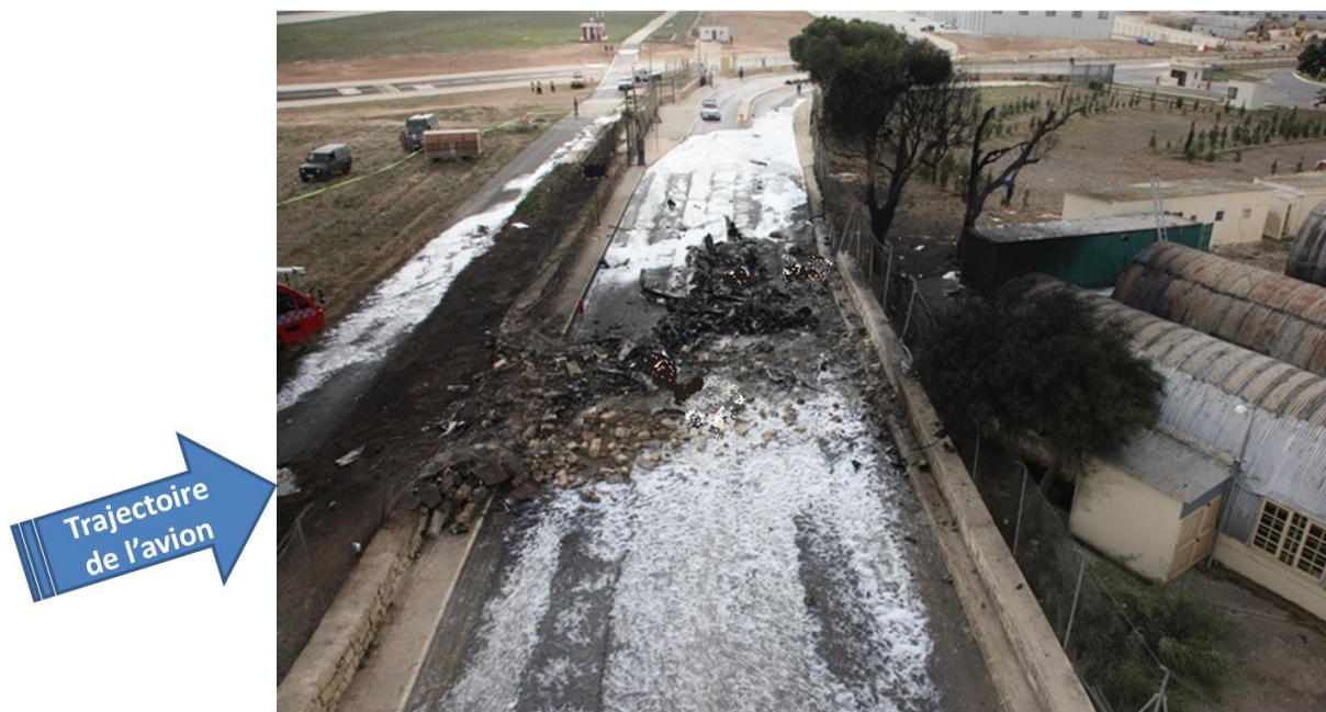
Dommages au mur d'enceinte, à la route et aux bâtiments environnants
