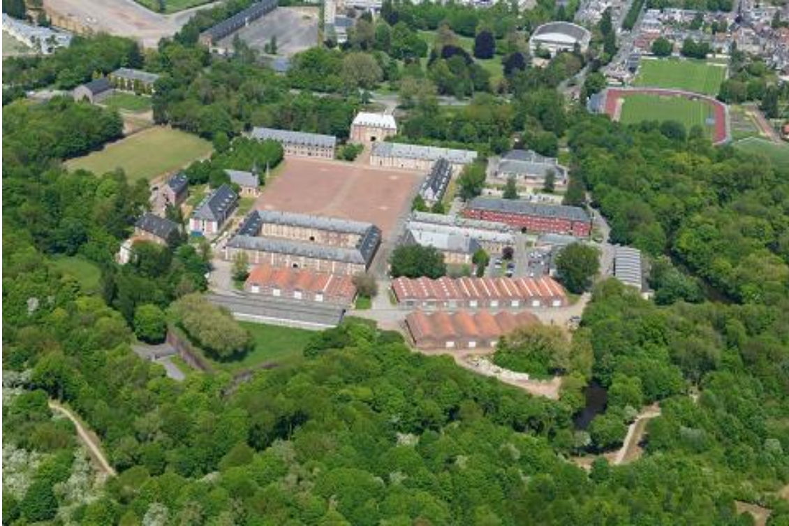
Citadelle d'Arras. Crédit photo : CUA.
