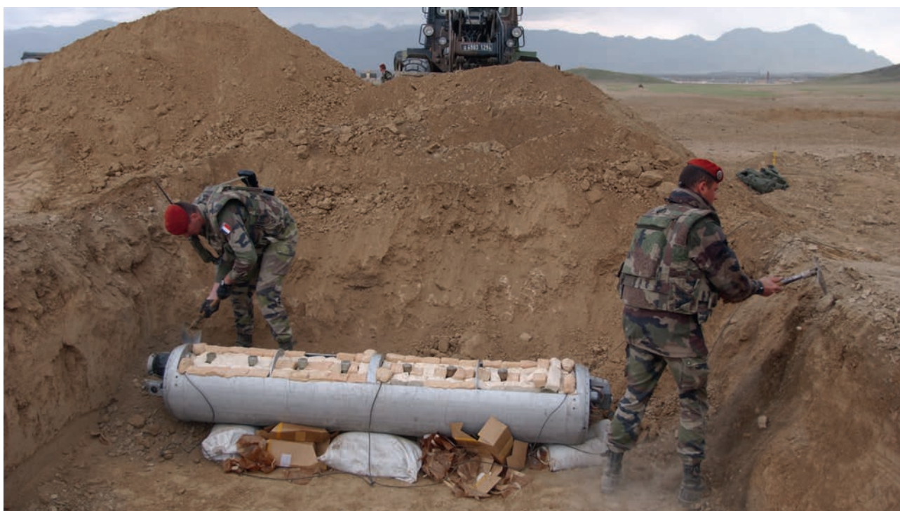
Dépollution d'engins explosifs..
