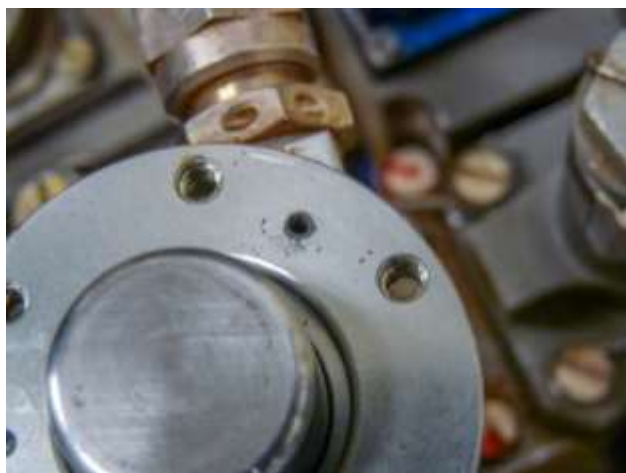
Présence de sable à l'embouchure du conduit d'air P2 sur le plan de joint du couvercle
