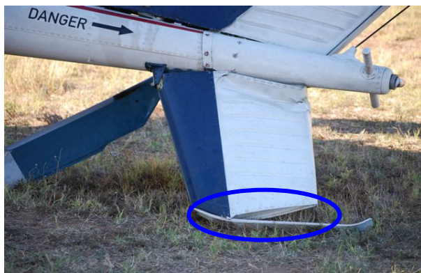
Photo 6 : déformation de la béquille
