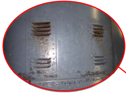
photo 2 : ouïes d'aération de la soute à équipements arrière
