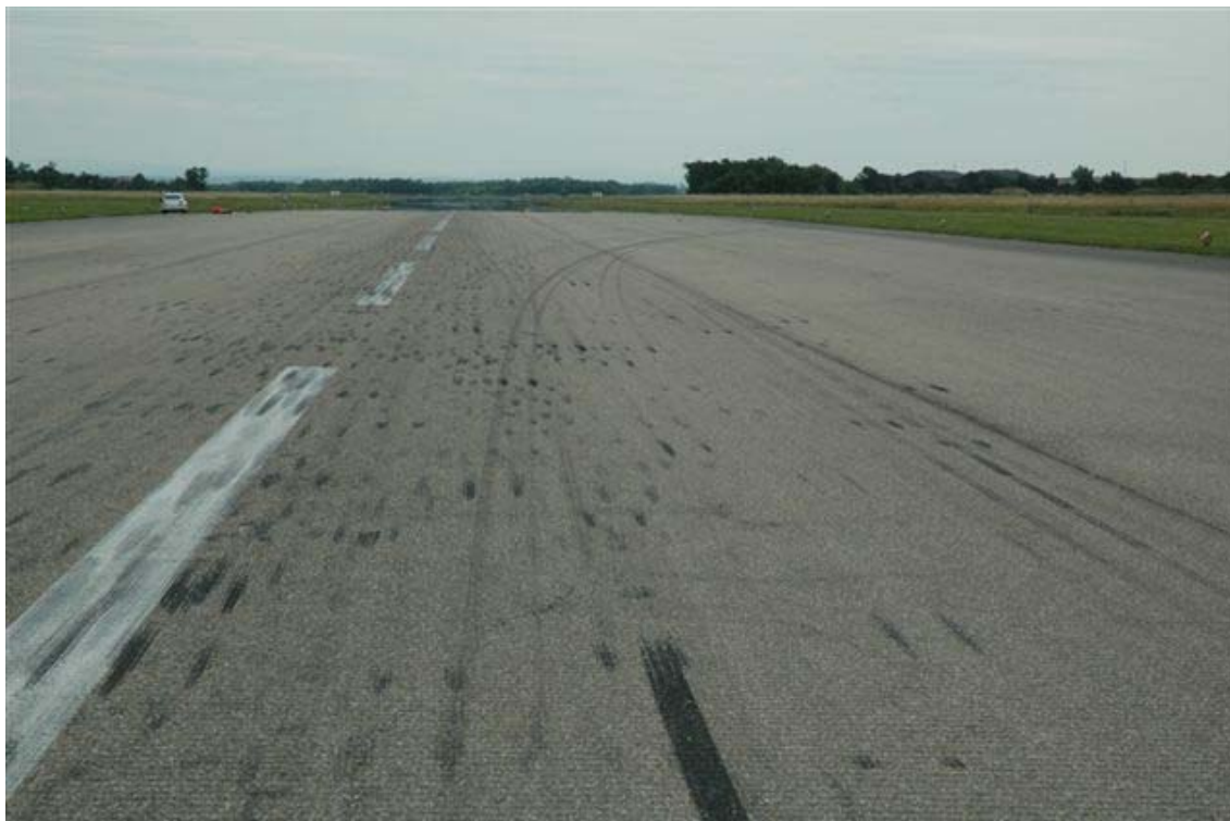
Vue des traces de pneumatiques sur la piste (début d'apparition des traces) 10
