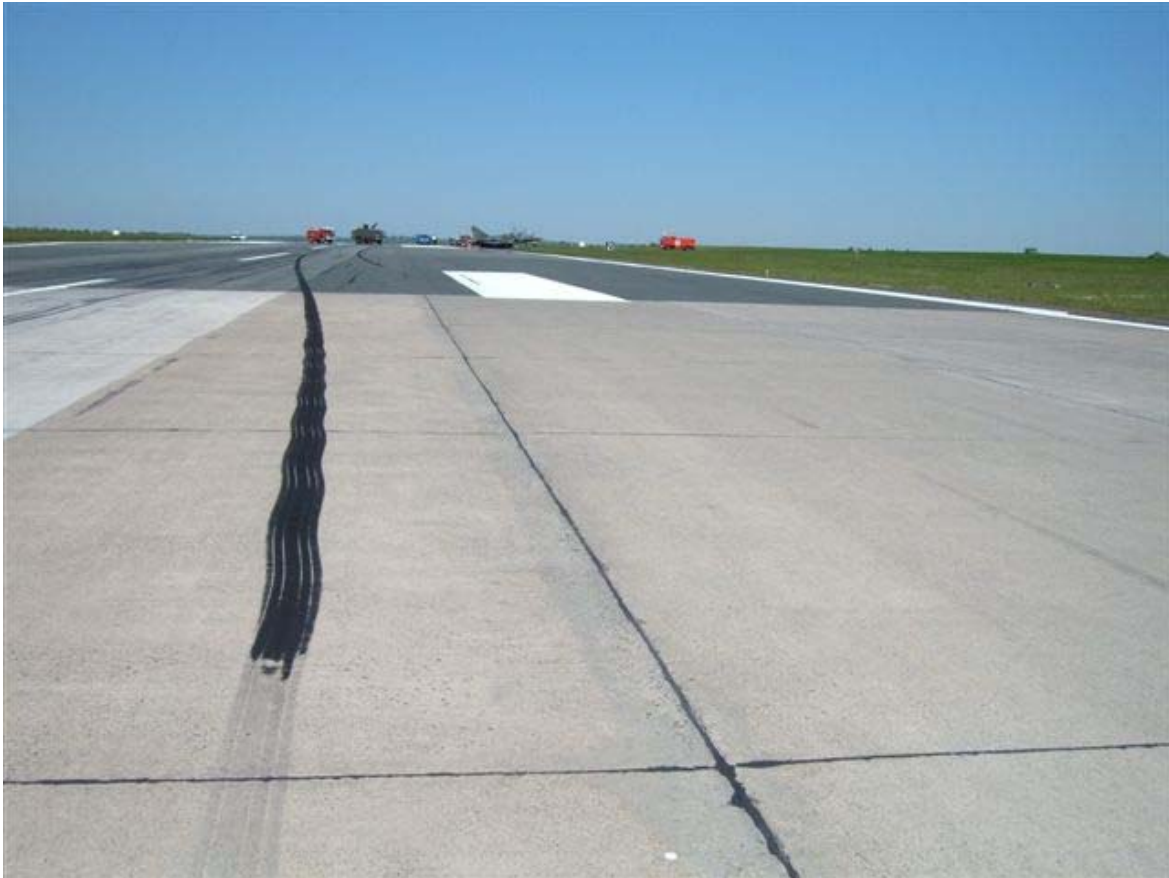
Détail de la trace laissée par le pneumatique de la roue gauche
