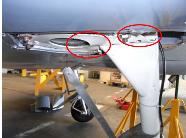
Endommagements de la platine inférieure de l'atterrisseur principal droit, vus de profil droit
