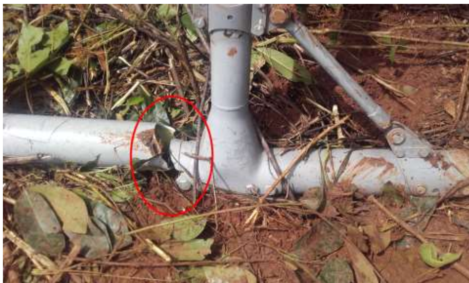
Figure 3 : endommagement du patin droit
