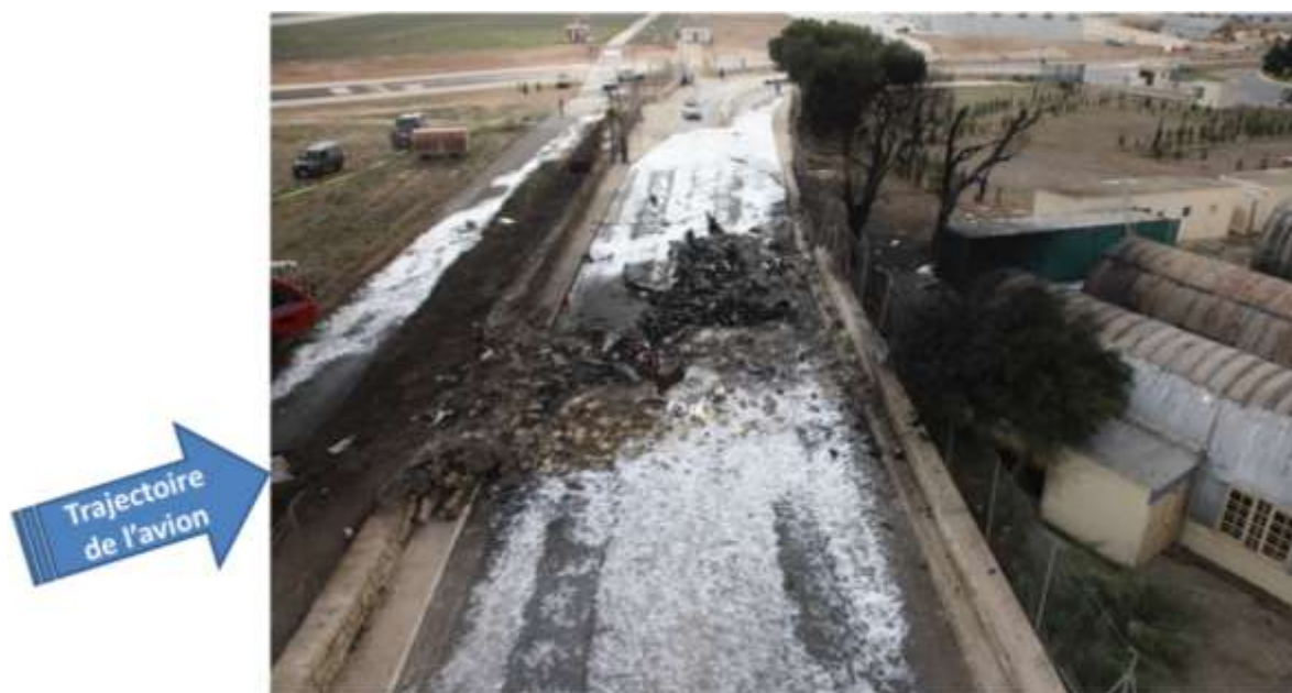
Figure 2 : dommages au mur d'enceinte, à la route et aux bâtiments environnants
