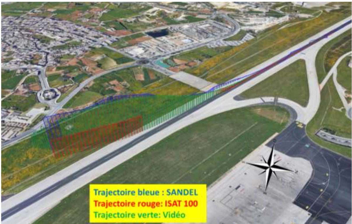
Figure 32 : trajectoires comparatives de l'avion après reconstitution (vue côté est de la piste)
