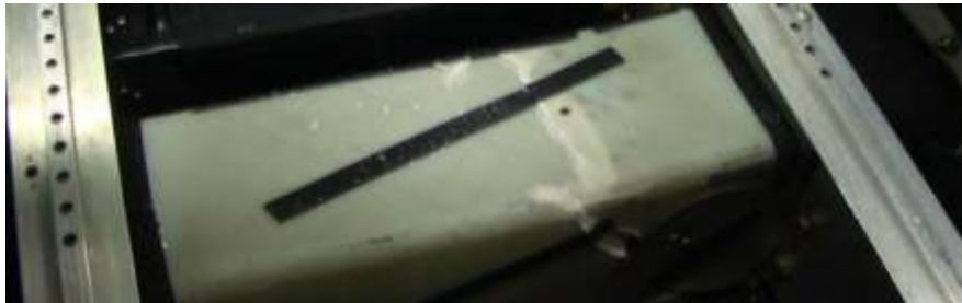
Vue du longeron fissuré
