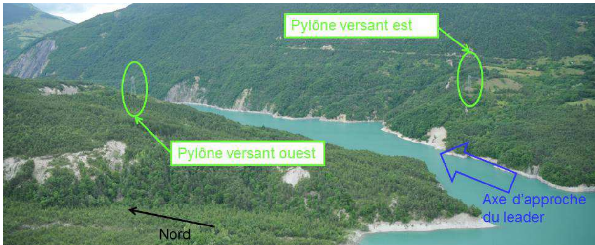
Vue de la ligne à haute tension
