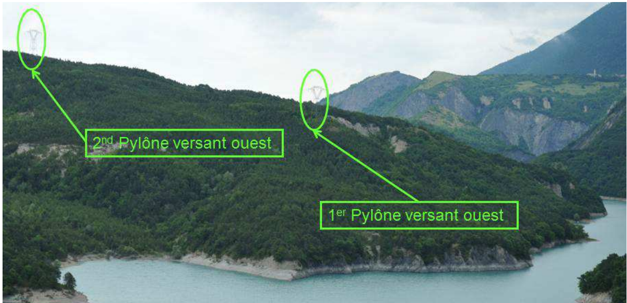
Vue des pylônes à 500 ft environ
