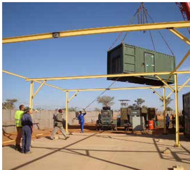
Installation d'une centrale électrique.
