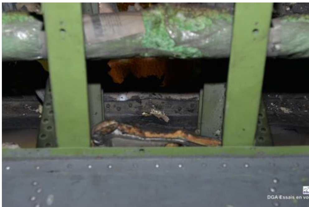
Vue plancher soute déposé
