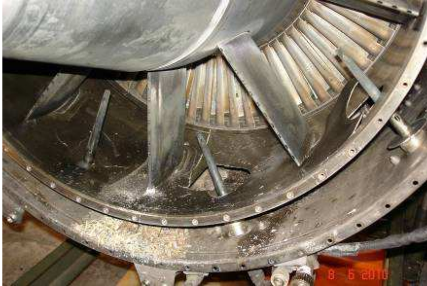
Détérioration du carter au niveau des sondes T7
