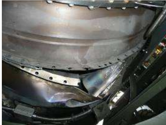
Ouverture à la jonction de la turbine BP et du raccordement
