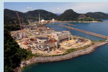
La construction d'Angra 3, Etat de Rio de Janeiro. Crédit : Eletronuclear
