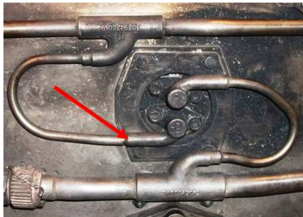
Vue de la rupture injecteur n°4
