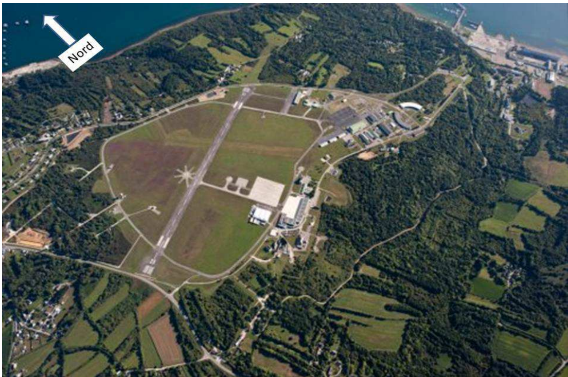
Vue aérienne de la base de Lanvéoc Poulmic
