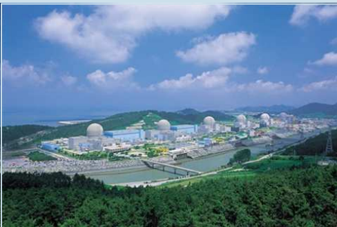
La centrale nucléaire de Yonggwang récemment renommée Hanbit, province de Jeolla du Sud, République de Corée. Crédit photo : Korea Hydro and Nuclear Power (KHNP)
