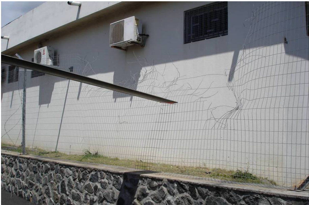
Grillage déchiré par le rotor
