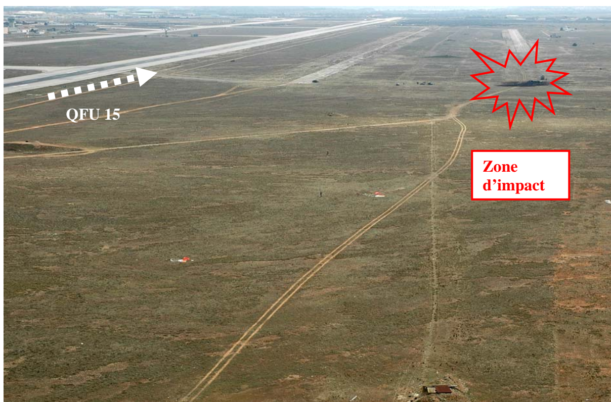
Vue aérienne, orientée vers le secteur Sud, situant la zone d'impact
