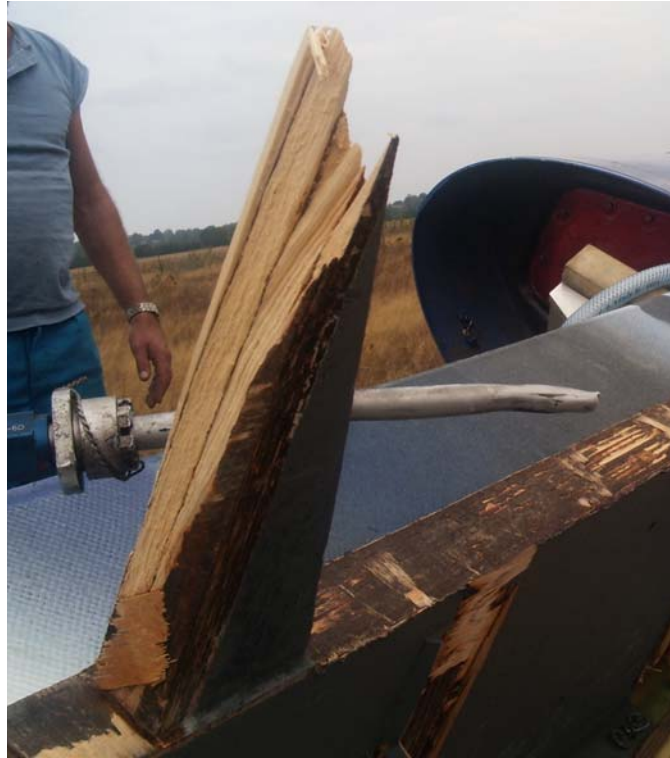
Vue du profil de rupture gauche du cadre 2 le lendemain de l'évènement
