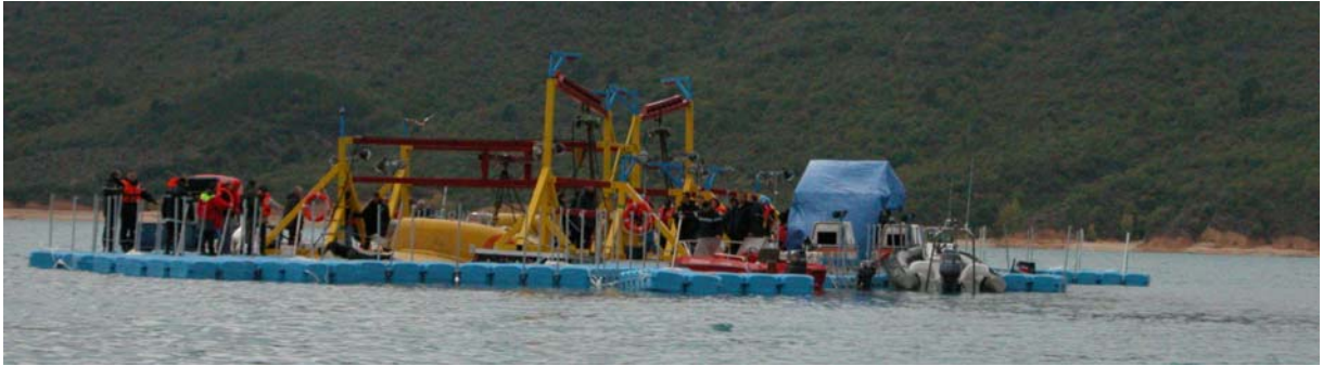
Plate forme mise en place par la DDSC pour la remontée de l'aile sur le lac
